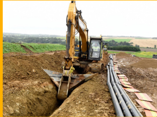
Converter station route. Ruta a estación convertidora.
